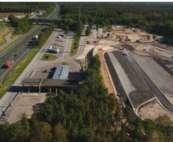
Rastanlage Dammer Berge auf der BAB A 1 während des Ausbaus.
